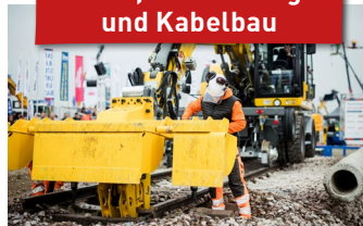
Musterbaustelle Kanal-, Rohrleitungs- und Kabelbau
